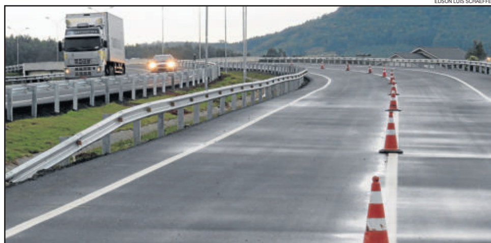
Último trecho liberado foi o do viaduto em Tabai
