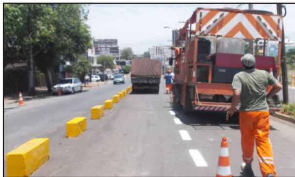
Avenida deve ser entregue no fim deste mês. Ontem, trabalhos foram concentrados nas pinturas
