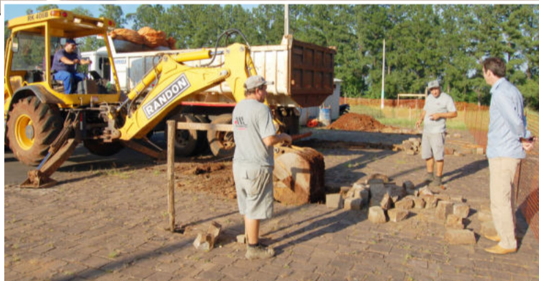
Obras de construção do pavilhão multiuso estão em andamento
