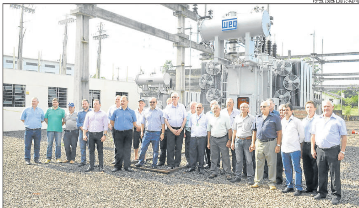
Novo transformador garante atendimento da demanda de energia para os próximos 10 anos
