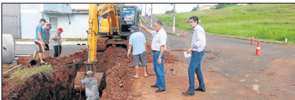
Na Avenida Leopoldo Schneider, Município melhora canalização pluvial
