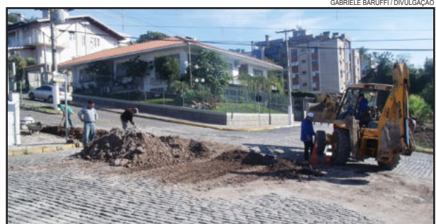
Obras Irmão José Sion
