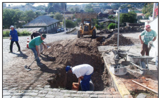
Obras Dante Grossi
