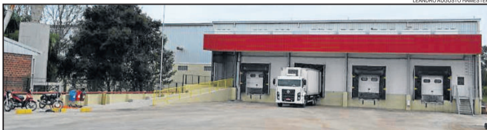
Lado externo do Centro de Distribuição
