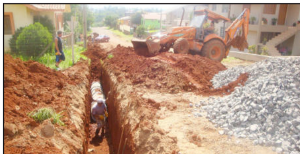
Drenagem antecede a pavimentação com blocos de concreto
