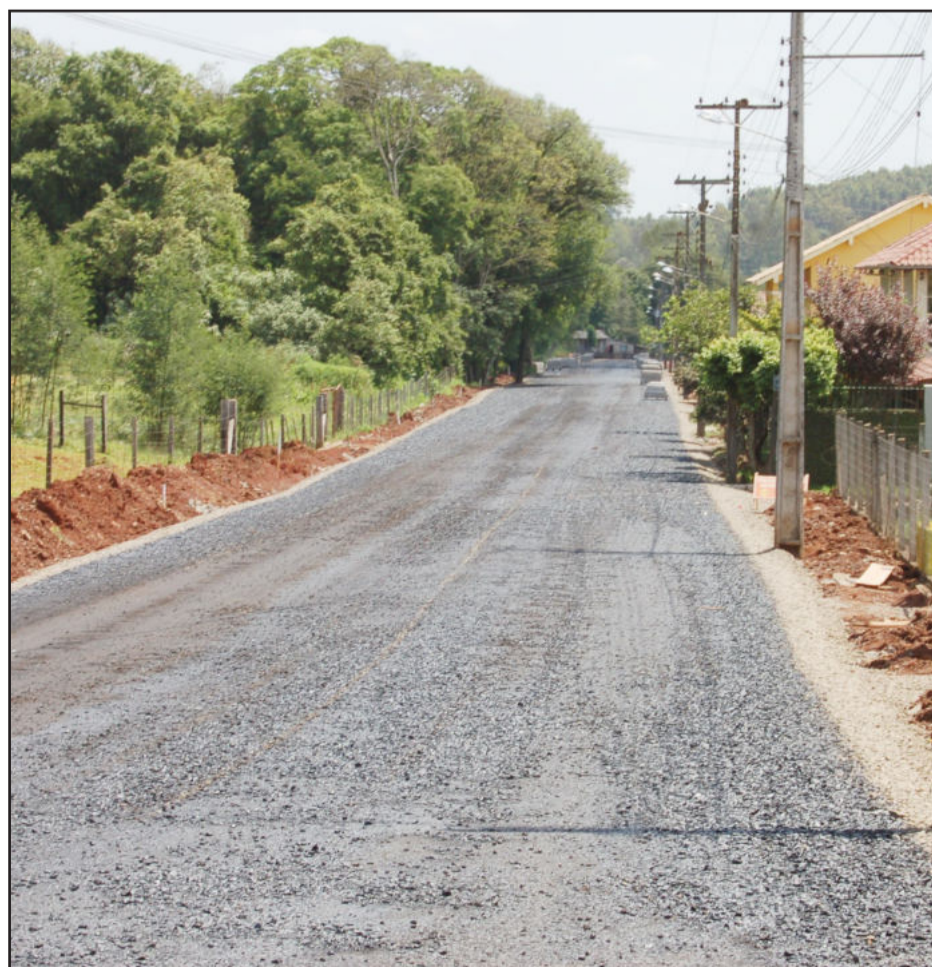
Rua Hatto Brönstrupp: falta receber a camada asfáltica final
