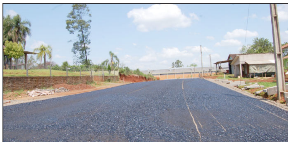
Rua Osvaldo Dienstmann: falta receber a capa asfáltica final
