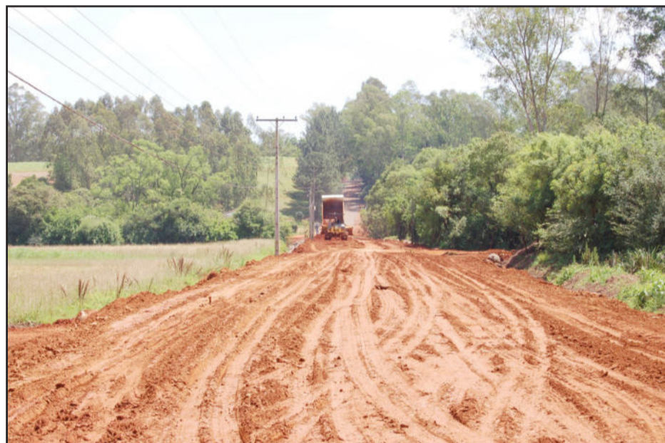
Obras de pavimentação da Estrada de Linha Ribeiro estão na fase de aterro e terraplenagem da baixada
