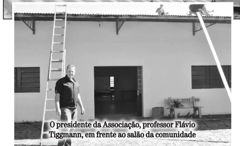
Reforma do telhado paga totalmente com recursos próprios
