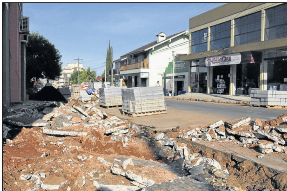
Obras estão ocorrendo na quadra entre as ruas Gustavo Schuck e Senhor dos Passos
