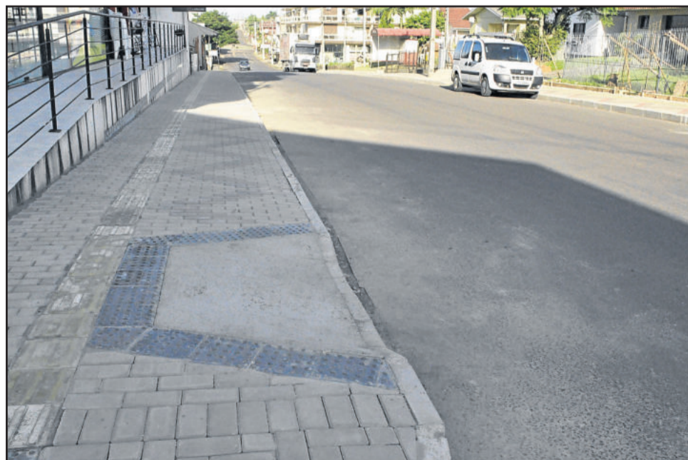
Na quadra entre as ruas Evaldo Hilgemann e Gustavo Schuck, as obras estão concluídas
