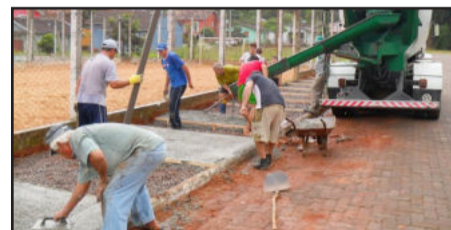
Mutirão para construção da calçada ao redor do campo
