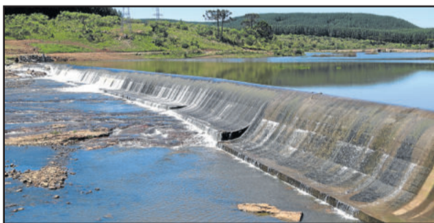
Hidrelétrica Cazuza Ferreira fornecerá energia limpa a mais de 30 mil pessoas
