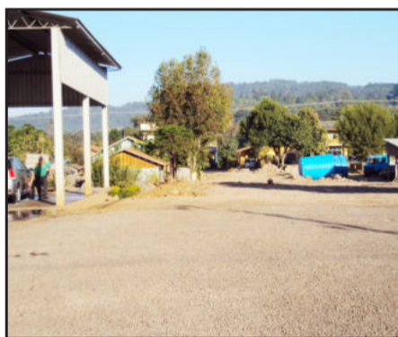
Abertura de nova rua no Centro próximo ao posto da Cidade
