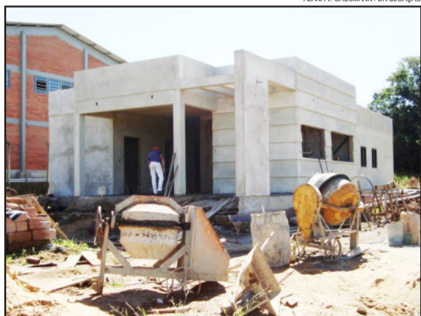
Novo Posto de Saúde do Bairro Teutônia segue em construção
