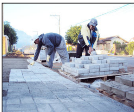
Pavimentação de calçadas em 3 ruas no Centro
