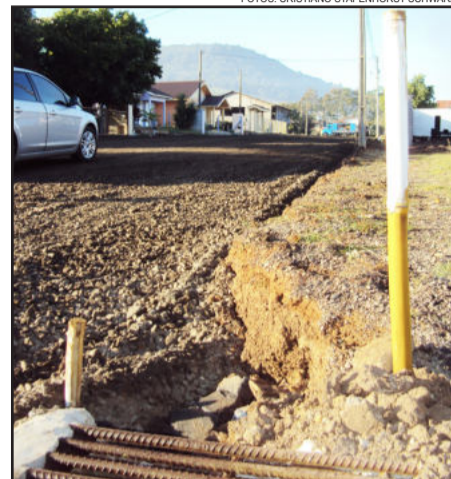
Base para asfalto pronta na rua 24 de Março
