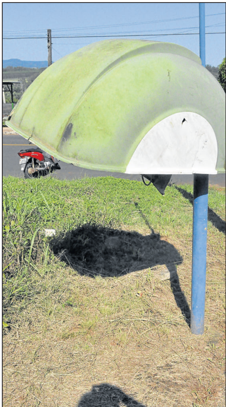
Orelhão da Rua José Gomes da Silva, esquina com a Ernani Júlio Sippel, está danificado em razão do vandalismo
