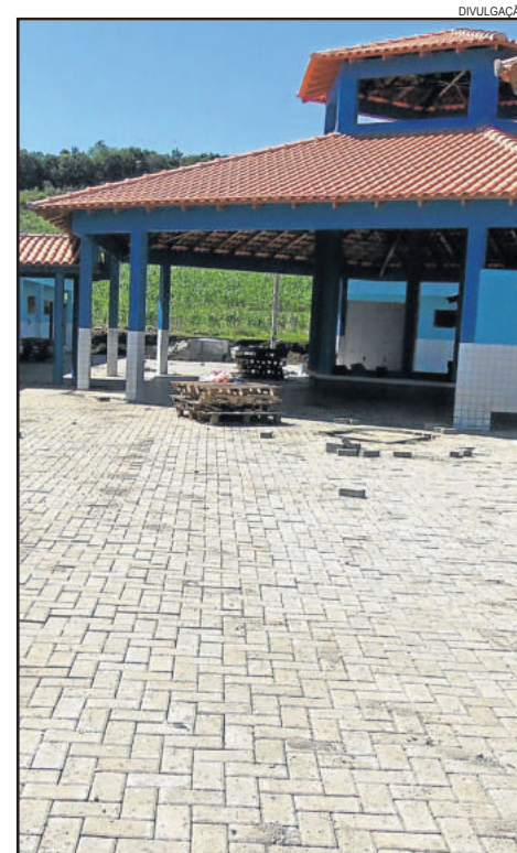
Paviesse já foi colocado na parte interna da escola
