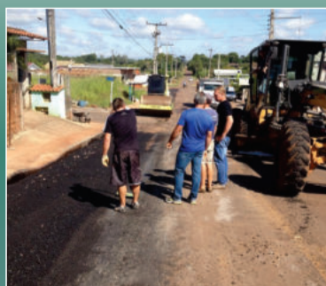
Tapa buracos em vias asfálticas
