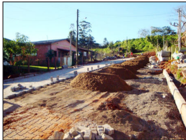
Pavimentação de blocos de concreto na Rua Jorge Pedro Stroher
