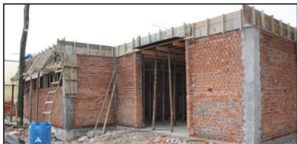
Novos banheiros são construídos no Parque da Fenachamp
