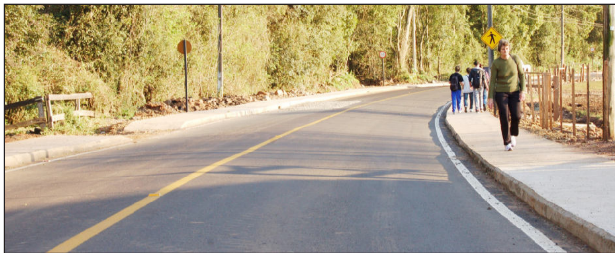
Trecho asfáltico que danificou está em fase final de recuperação
