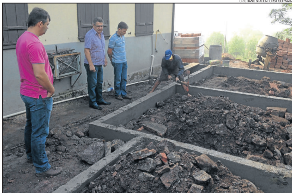
Sieben, Marasca e Lucian acompanham obra de perto
