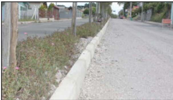
Base concluída e meio-fio colocado destaca envergadura da obra
