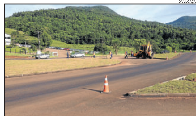
Obras foram concluídas no final de semana
