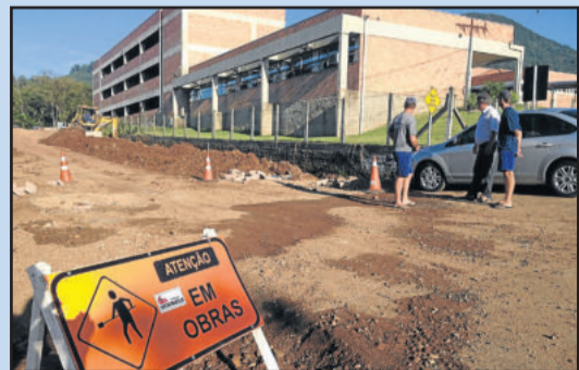
Obras contam com apoio de equipes da Administração Municipal
