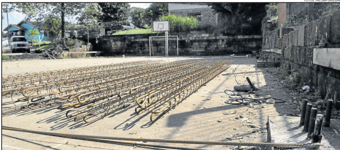
Parte do material já está na escola
