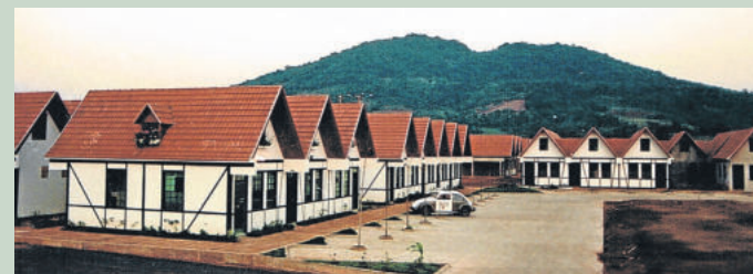
Centro Administrativo em fase de construção
