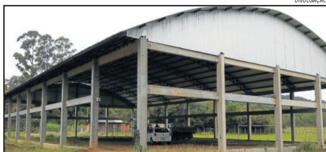
Cobertura metálica foi instalada na quadra poliesportiva em Santa Manoela
