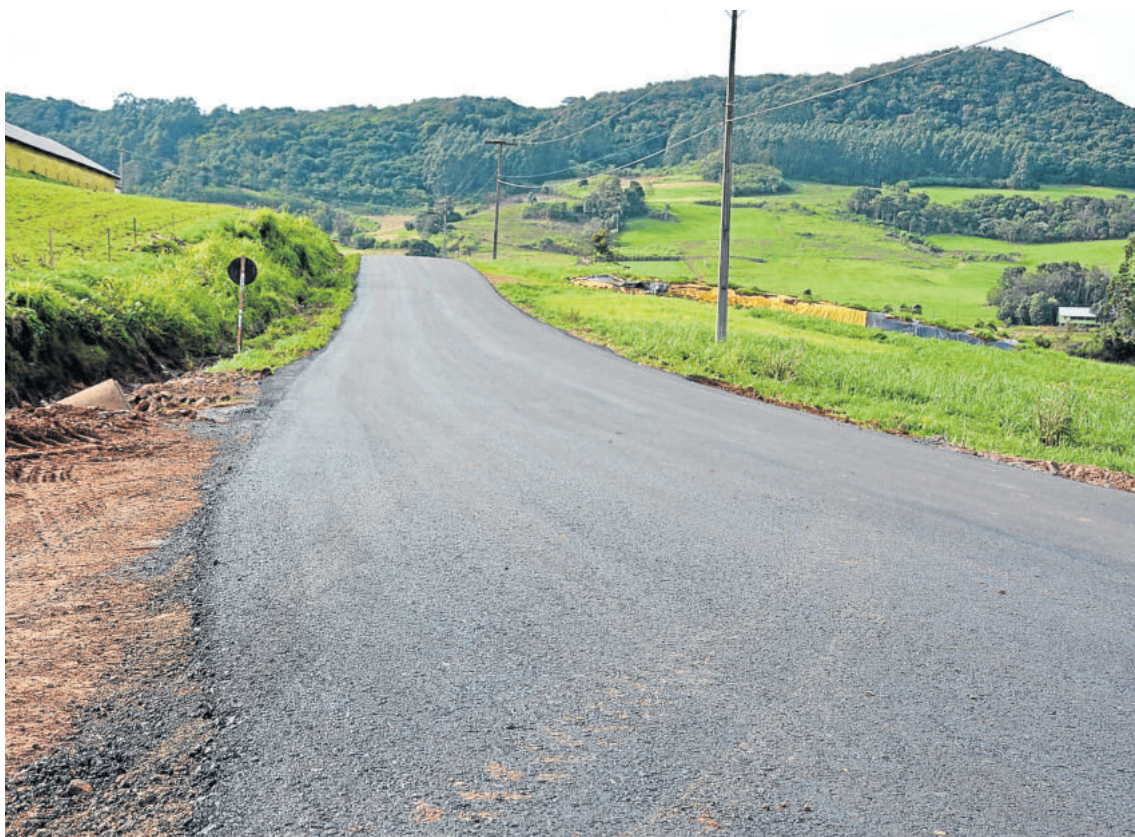
Recapeamento já está concluído, restando apenas a pintura da via para a conclusão da obra
