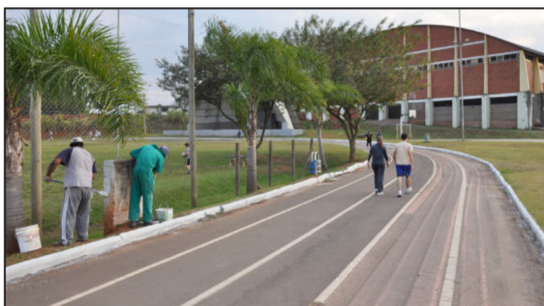
Pintura de meio fio no Parque dos Dick
