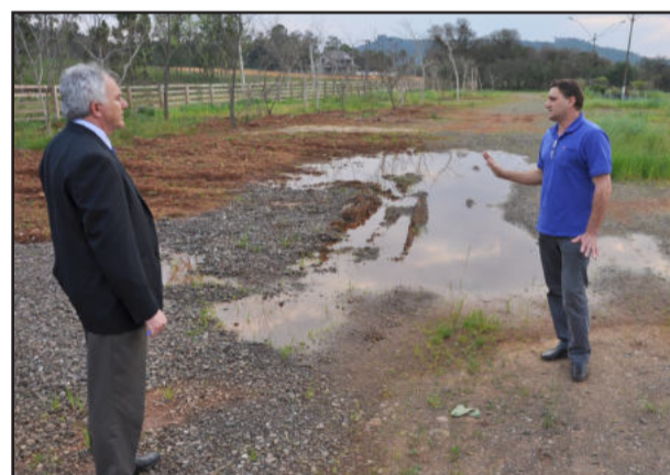
Schmidt e Adi conferindo obras no Parque de Eventos
