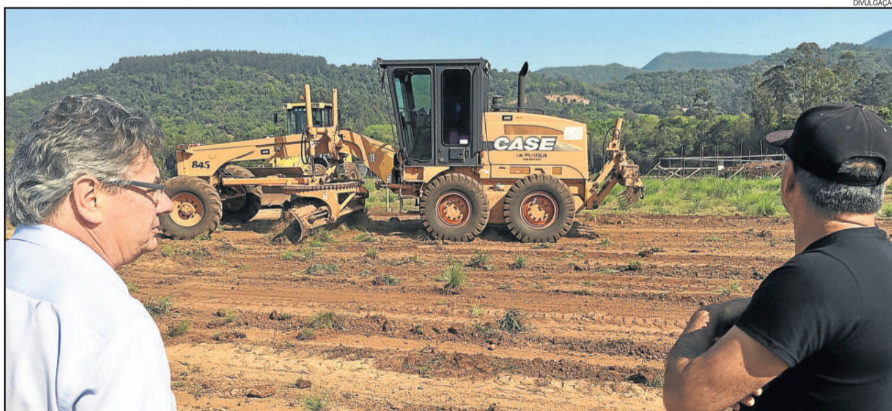
Marasca e Bagatini acompanham obras de perto
