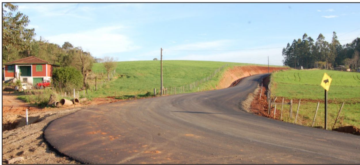
Asfalto de Linha Ribeiro tem etapa concluída
