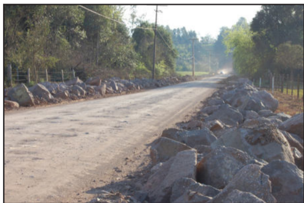
Trecho ainda está em fase de estruturação da pista
