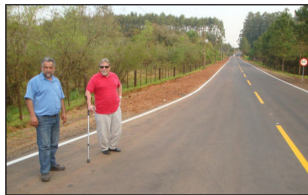
Nardi da Silva e Brönstrup visitaram a pavimentação asfáltica da rua Júlio de Castilhos
