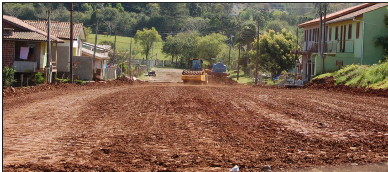
Avenida Otterno Schaeffer segue em obras no Bairro Canabarro
