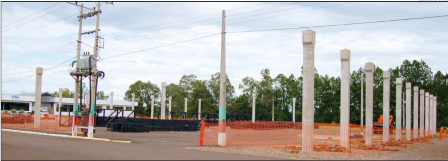
Avançam obras de construção do Pavilhão Multiuso no Centro Administrativo
