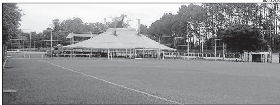
Montagem da estrutura na sede da Associação da Elegê começou a ser feita na quinta-feira
