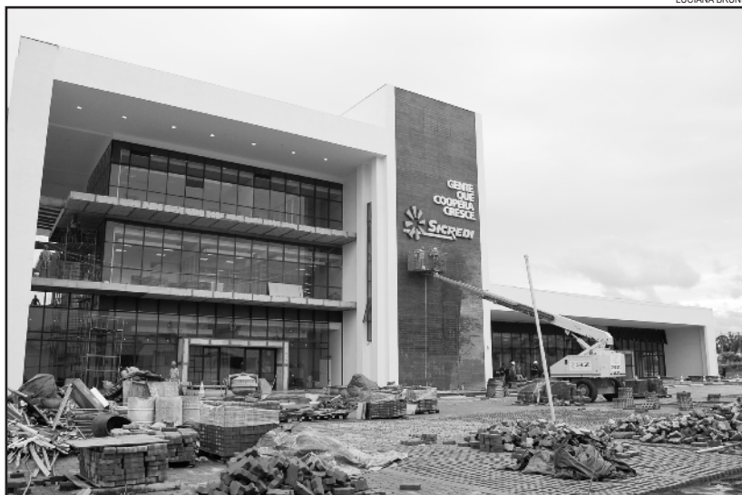
Obras estão na fase final
