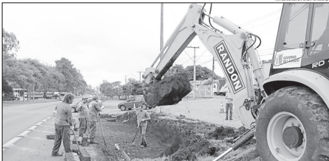
Estreitamento do canteiro antecede colocação de base para posterior asfaltamento
