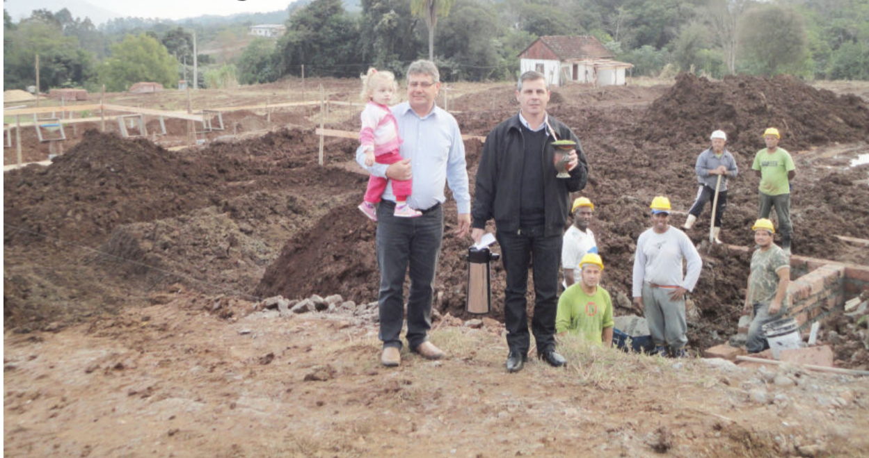
Prefeito Marasca com a neta Isabella acompanhou Machado na visita à obra da Escola Estadual
