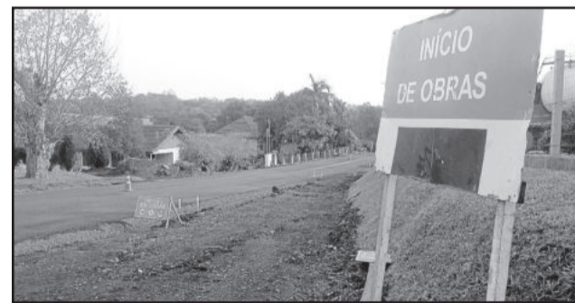
Serão quatro quilômetros de pavimentação
