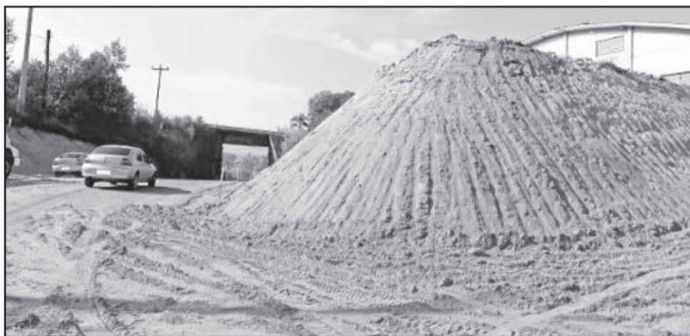
Pista foi rebaixada em 3,20 metros
