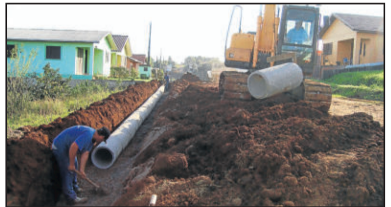
Pavimentação da Rua Osvaldo von Mühlen
