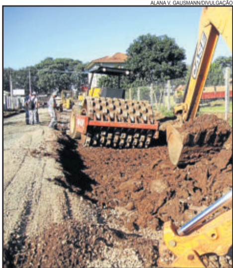
Pavimentação da Friedholdo Heilmann
