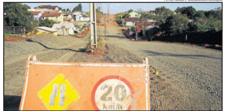
Pavimentação da Avenida 01 Leste
