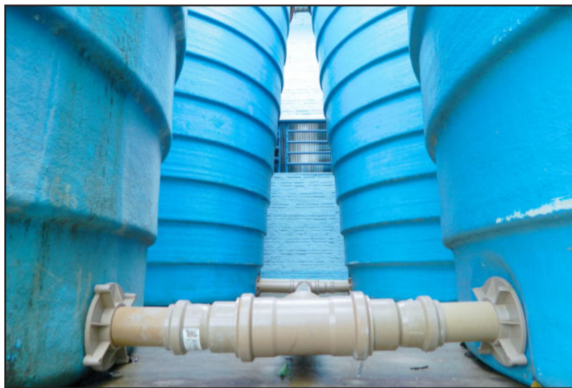
Recentemente foram reativados 4 reservatórios de água da chuva com capacidade de 80 mil litros juntos
