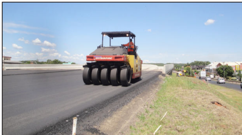
Elevada na Fazenda Vilanova está praticamente concluída
