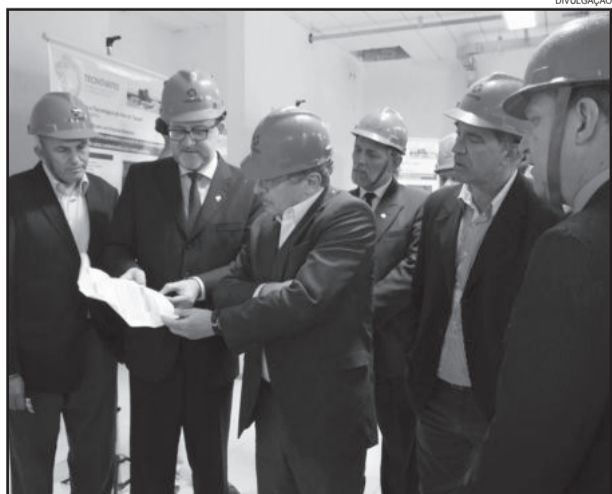
Governador visitou a obra do Tecnovates
