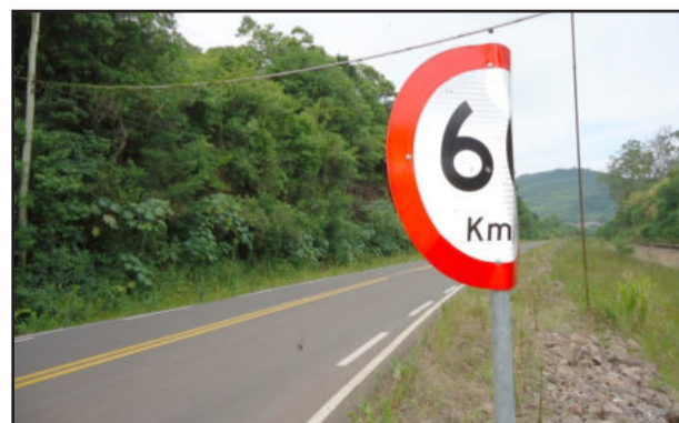
Placas novas foram danificadas
