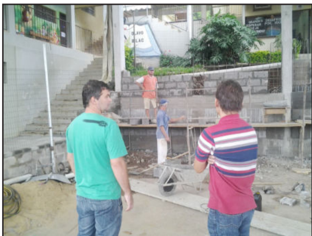
Sieben e Lucian acompanharam a construção do muro na Berlim
