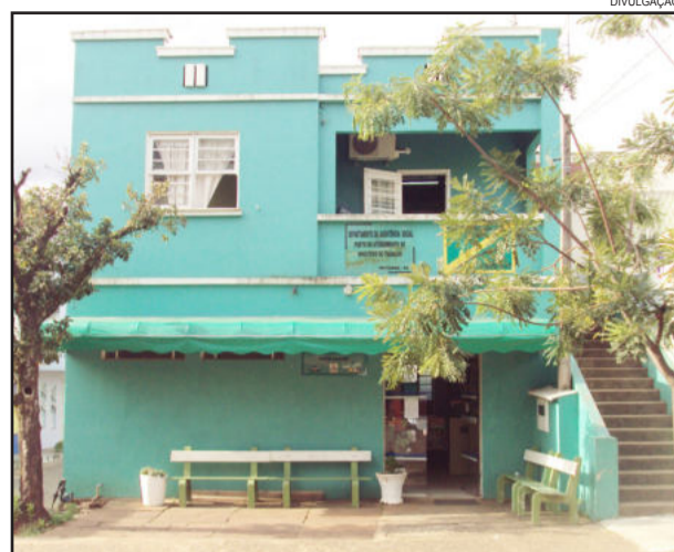
Toldo instalado em frente ao prédio do CRAS
