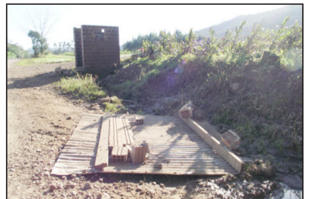
Parada de ônibus danificada pelas águas
