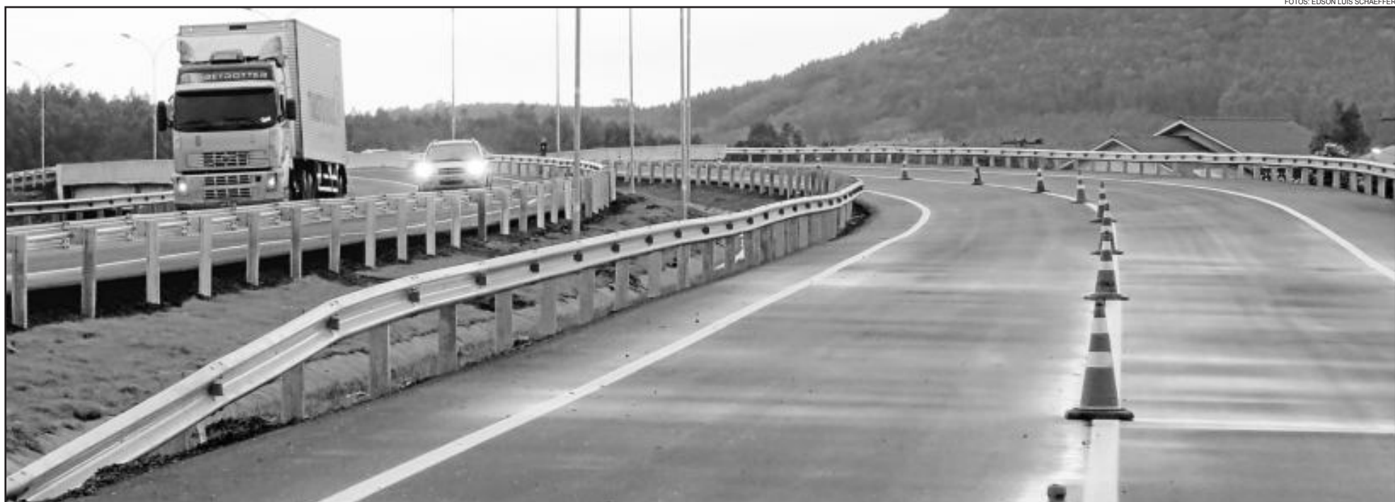
Trânsito de veículos sobre o viaduto em Tabai foi liberado na tarde ontem
