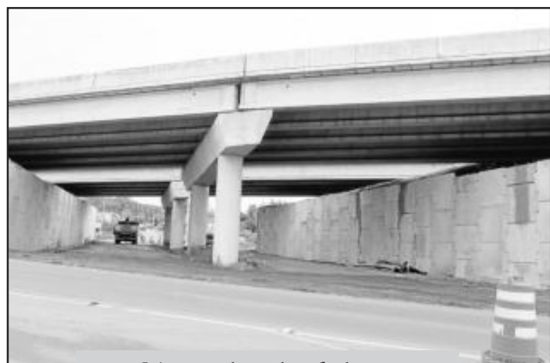
Liberação do viaduto facilitará a travessia entre um ponto e outro em Tabai
