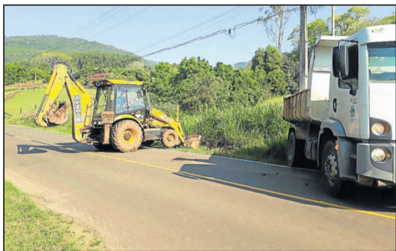
Limpeza na lateral do asfalto da Seca Baixa
