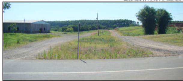
Avenida defronte ao CTG é uma das vias que serão pavimentadas
