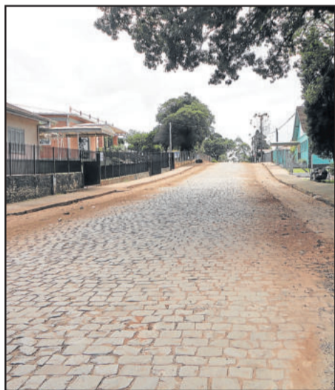
Rua Ewaldo Schaeffer, no Bairro Canabarro, antes da obra
