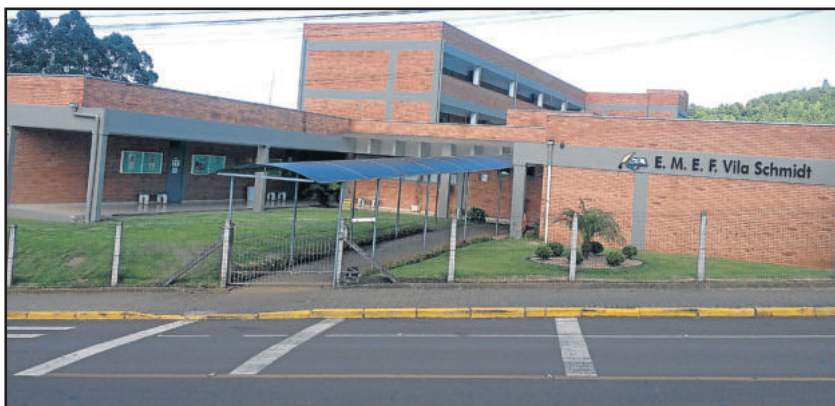
Emef Vila Schmidt teve anexo de prédio com 3 andares
