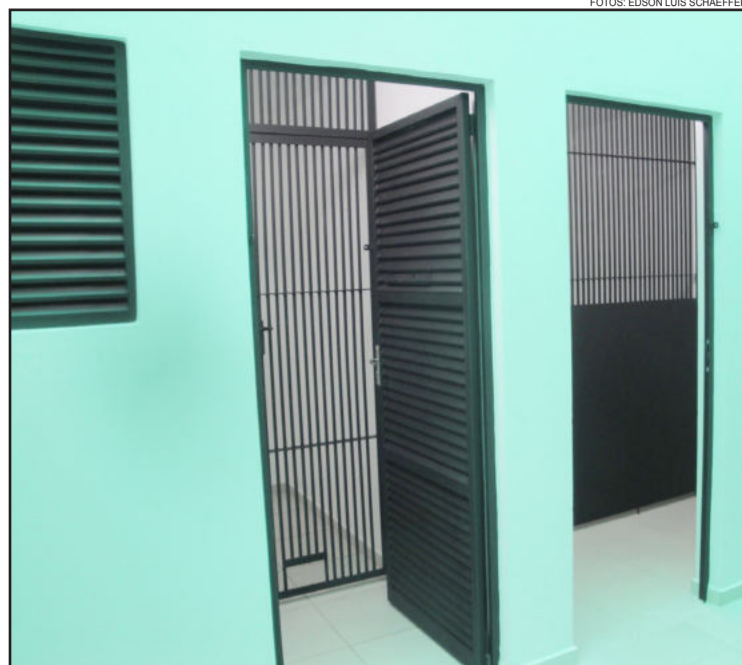
Ampliação possibilitou a construção de duas celas
