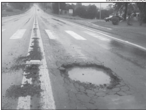
Cratera na pista chega a tomar quase metade de um lado da pista
