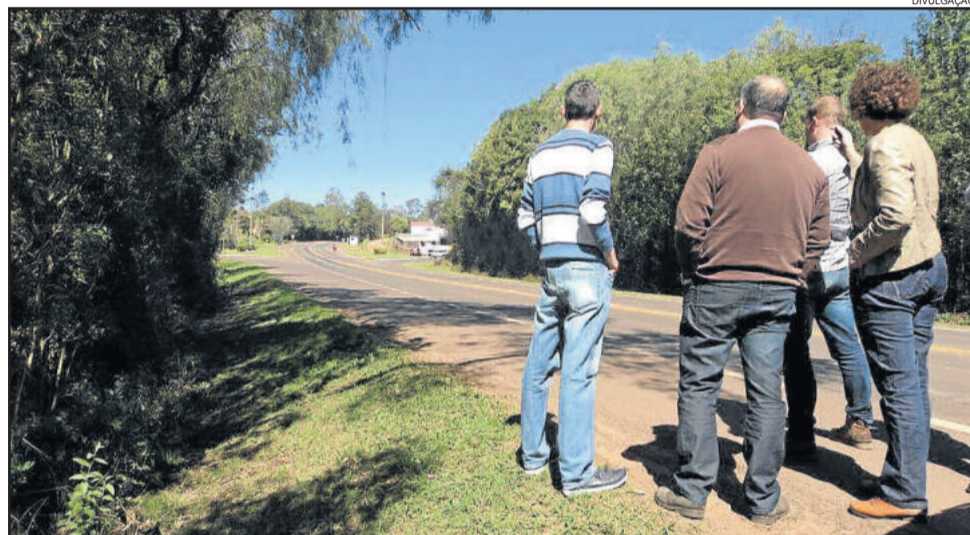
Técnicos do Daer fizeram uma vistoria in loco dos pontos críticos da Via Láctea
