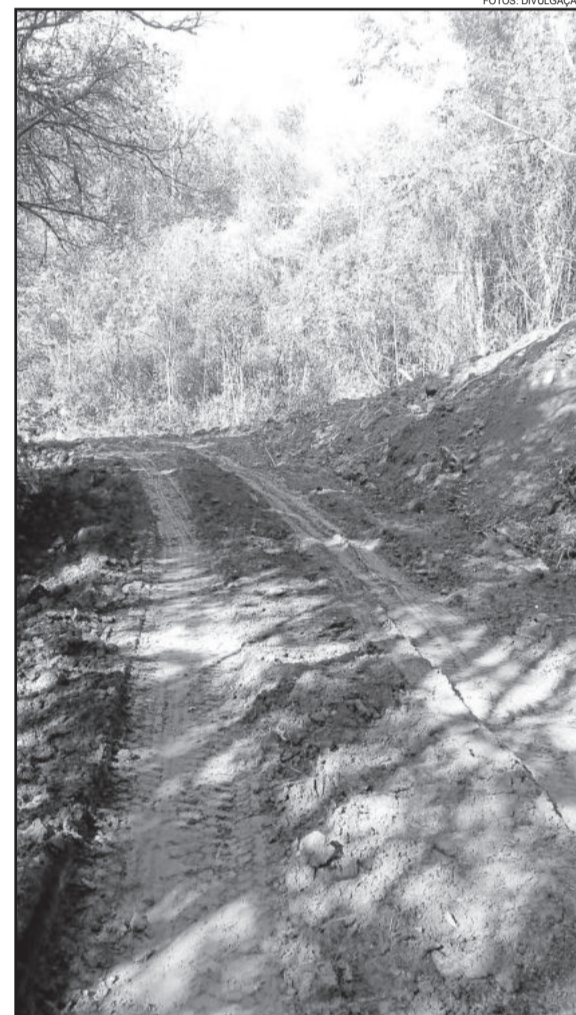
Segundo moradores, o novo acesso apresenta condições precárias
