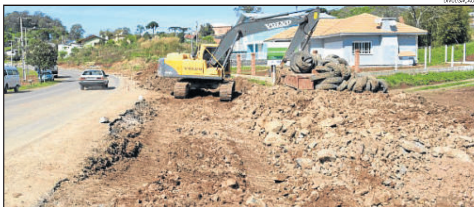
Obras da nova ciclovia evoluem
