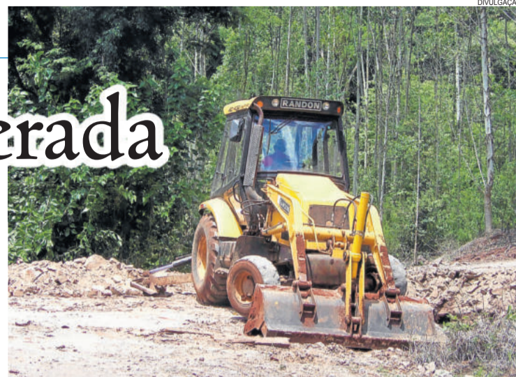
Máquinas trabalham no local para concluir ponte o quanto antes possível
