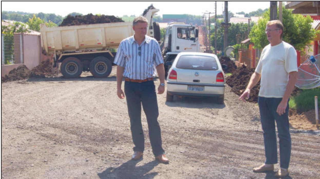
Ariberto (e) e Hércio vistoriaram andamento das obras
