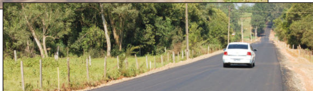
Pavimentação asfáltica em Linha Ribeiro está concluída
