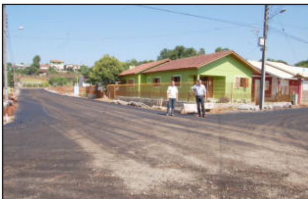
Ruas Reynaldo Augustin, 15 de Novembro e parte da João Musskopf estão para receber camada final de asfalto
